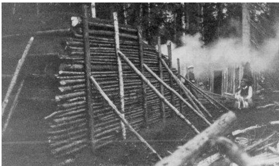
Nytänd liggmila i Bjurfors, Västmanland 1916. På bilden ses den konstruerade väggen, balkron, tydligt. Just denna liggmila stöttades upp med snedställda stöttor. Från Skogsbibliotekets bildarkiv, negativnr 13673
